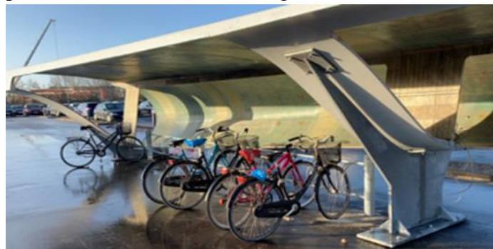
Figura5. Reutilización de palas de aerogenerador como aparcamiento de bicicletas. Fuente: Energías renovables ( https://www.energias-renovables.com/eolica/nuevo-retro-para-la-eolica-reciclar-14-20200617 )
