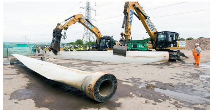
Figura 5: Desmantelamiento de un aerogenerador. Residuos Profesional 2015.
