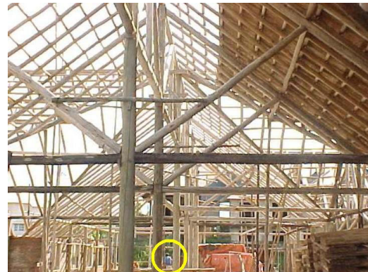
Figura 6: Estructura de E. grandis , en un restaurante para 1000 personas. Colón, Argentina
