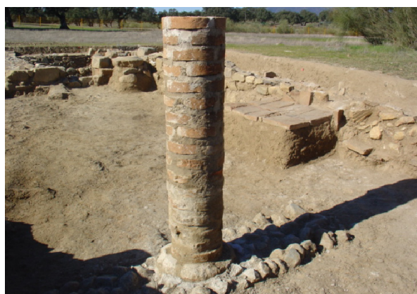
Fig. 6e - Columna de opus testaceum.
