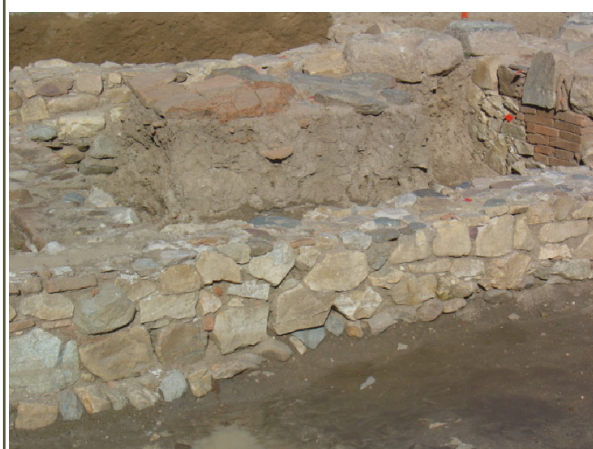
Fig. 6c - Muros de piedras sin argamasa de la Casa de la Columna.
