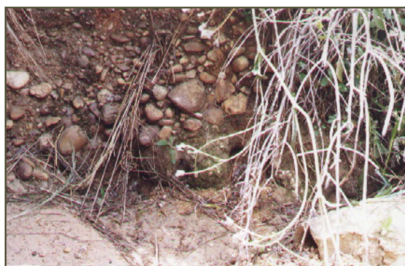
Fig. 10 - Estratificación del firme de la vía.
