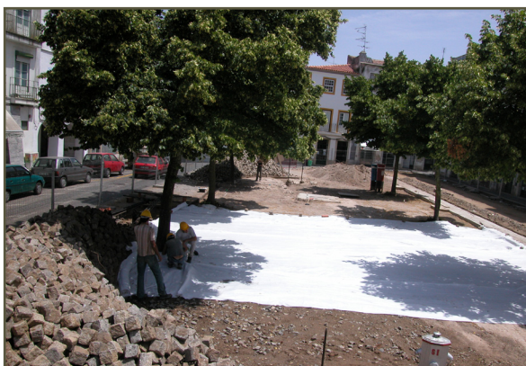
Fig. 8 – Cobertura com geotêxtil da totalidade do pavimento identificado, no âmbito do acompanhamento
