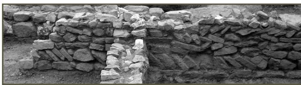
Fig. 18 – Parede com aparelho misto
