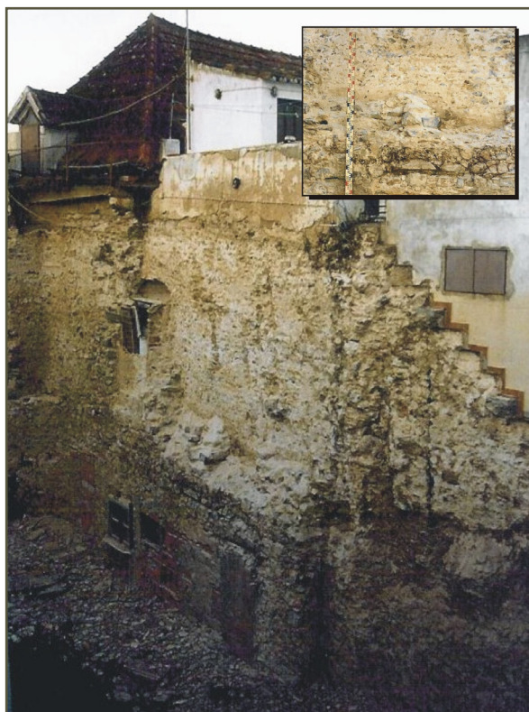
Fig. 8 - Troço da muralha almôada (UE402) colocado a descoberto durante os trabalhos levados a cabo na "Pensão Castelo": ainda que se conserve numa extensão considerável, a parede de muralha foi alvo de diversas intervenções em épocas mais recentes (abertura de vãos, desbaste parcial, etc.) que a alteraram profundamente.
