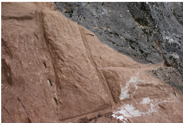
Fig.4. Marcas de cuña y serrado.
