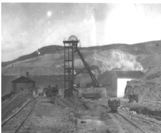
Foto 10 (Derecha) Malacate y Casa de máquinas AFRT (1910). Foto 11 (Izquierda) Malacate y Casa de máquinas. Foto ADD (2009).
