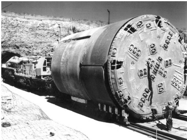
Figura 3. La ingeniería geológica permite la adecuación de nuestras infraestructuras a las peculiaridades del sustrato geológico
