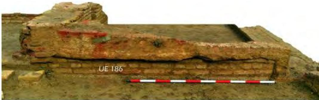
Fig. 26. Reparación a base de un potente enfoscado de mortero
