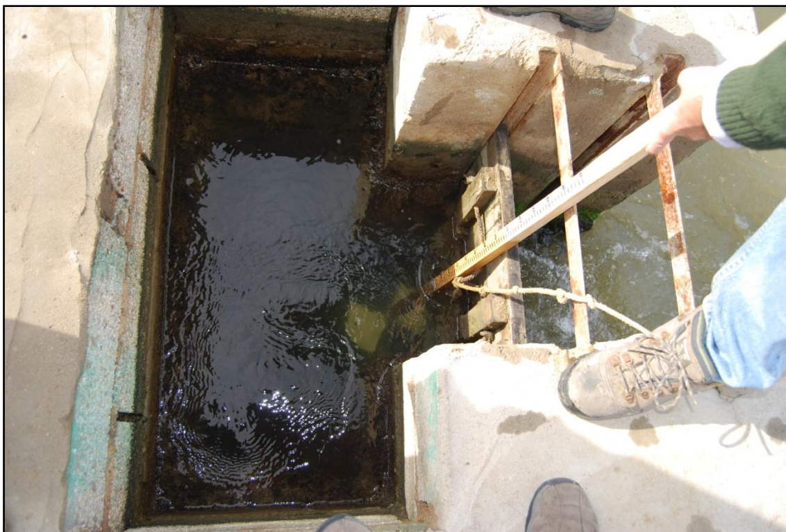
Figura 2.3. Fotografía de la efectucción de mediciones en la compuerta de la balsa 5C Norte, realizada por Juan Carlos Gutiérrez Estrada
