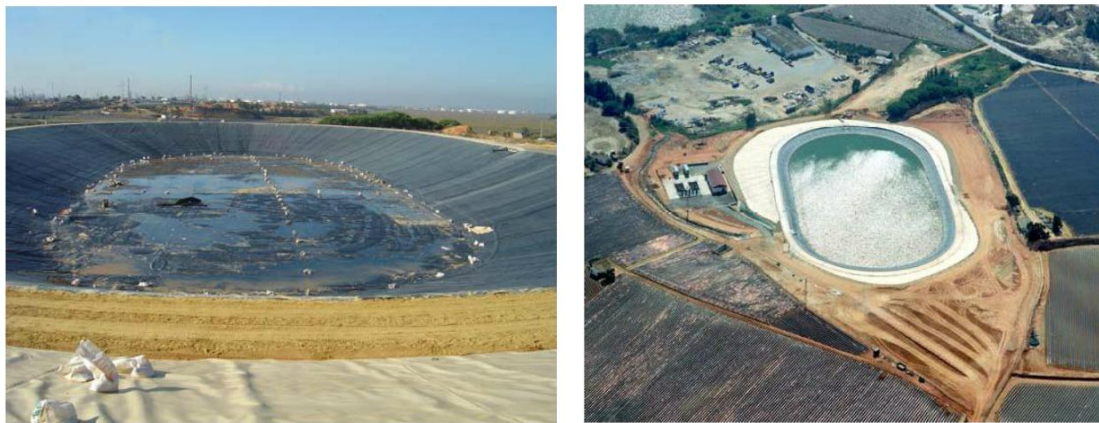
Figura 2.6. Balsa de regulación del sector I.
