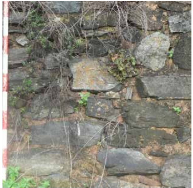
Figura 11: Detalle de la fábrica de mampostería sin enfoscado. Subtipo 5-2.
