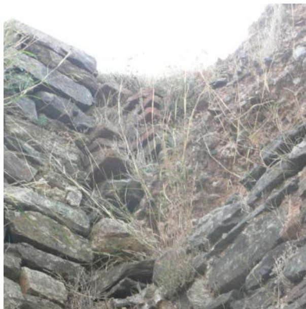
Figura 7: Detalle del adosamiento de las fábricas de la Torre 2 sobre Torre 1, y la presencia en esta última de restos de fábrica de ladrillos en lo que pudo ser una esquinera que enmarcaba el tapial.
