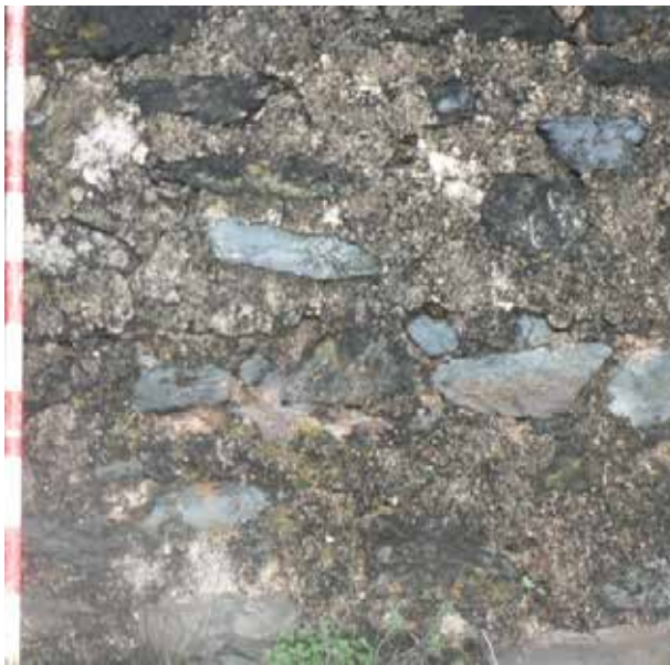
Figura 10: Detalle de la fábrica de mampostería con enfoscado a raspaterón. Subtipo 5-1.
