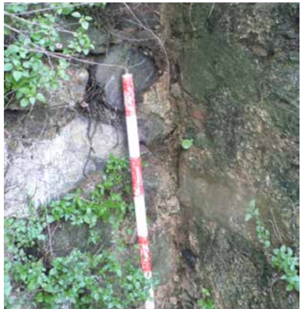
Figura 15: Relación estratigráfica entre la mampostería tipo 3 de la Torre 6, y la mampostería subtipo 5-1, del Lienzo E.
