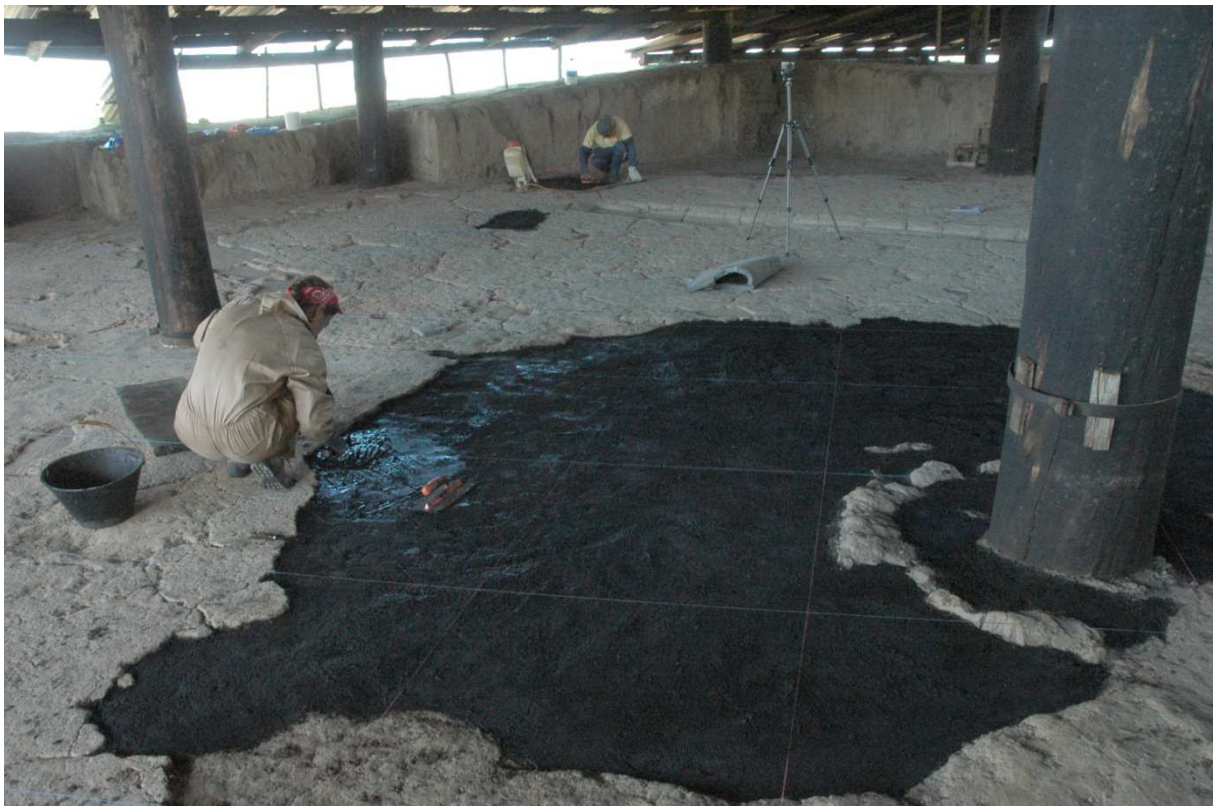
Figura 1. Puesta de chocoto sobre el cual se asienta el estuco compuesto por cal y arcilla.
