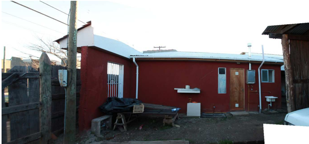
Figura 7. Trasera de Vivienda de fachada continua en Cauquenes.
