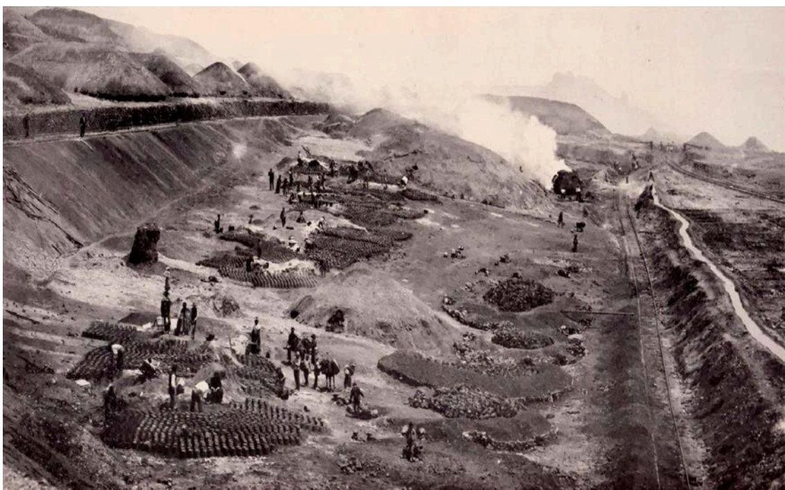
Ilustración 2 Sistema de calcinaciones en Riotinto llamados Teleras. Década de 1880.
