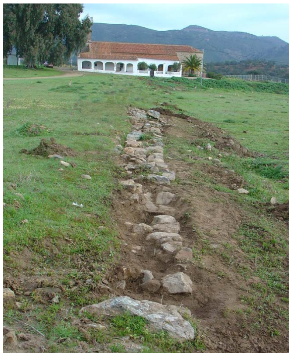
Fig. 3. Resultado de la limpieza superficial al sur la Ermita de San Mamés.
