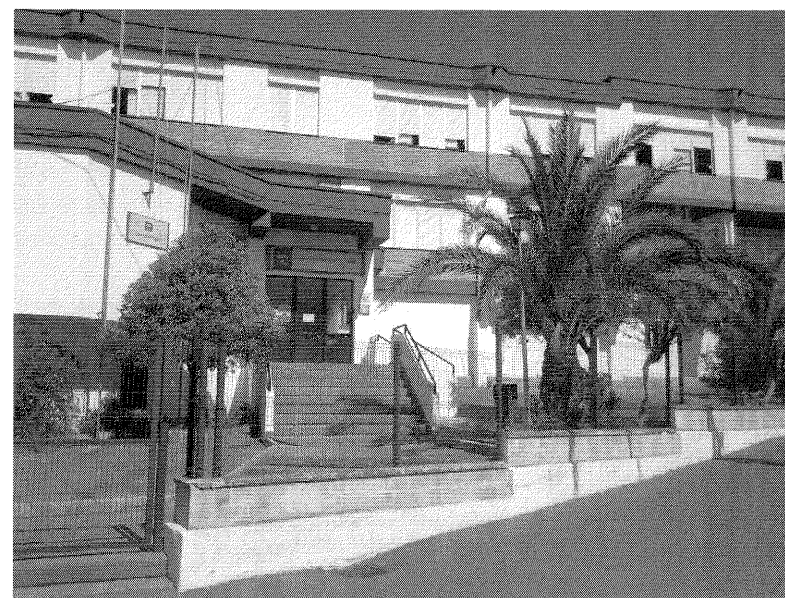
Figura 7.3. Puerta de entrada del CEIP Peñaluenga (Castillo de las Guardas-Sevilla).
