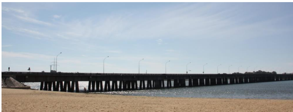
Figura 39 “Vista lateral puente del tinto”
