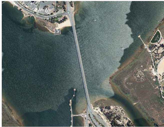
Figura 38 “Vista aérea puente del Tinto”
