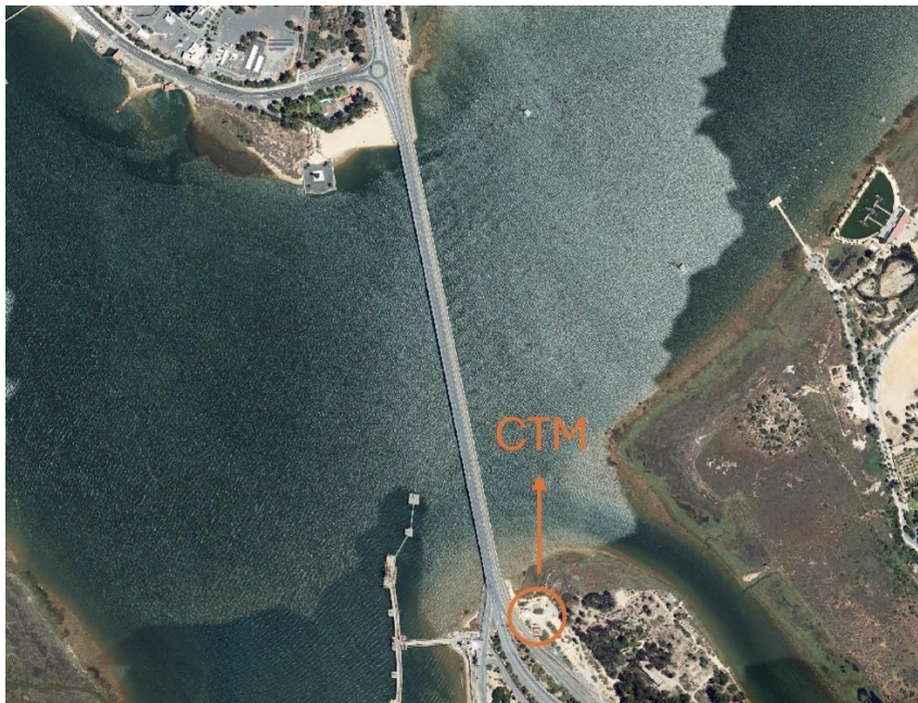
Figura 41 “Localización del centro de transformación”
