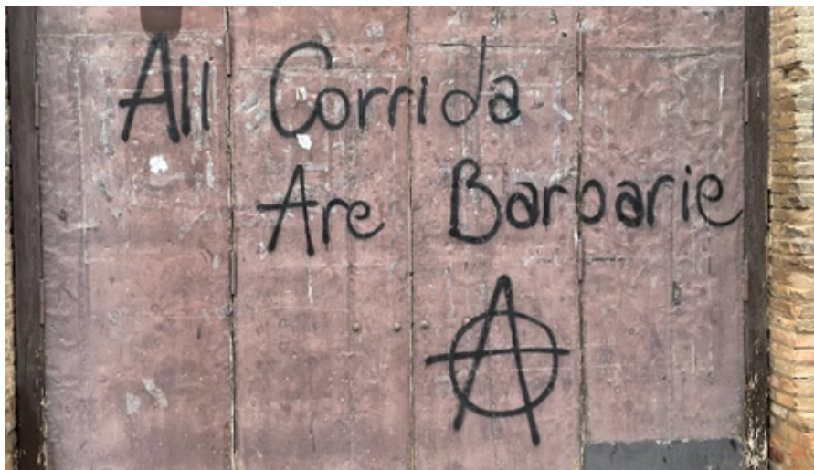
Figura 12. Fachada de la Plaza de Toros
