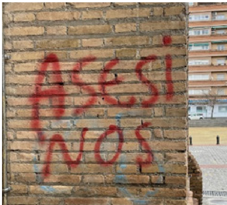
Figura 14. Fachada de la Plaza de Toros
