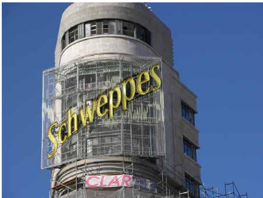
Imagen 2. Edificio Capital de Madrid (fuente: archivo fotográfico del autor)
