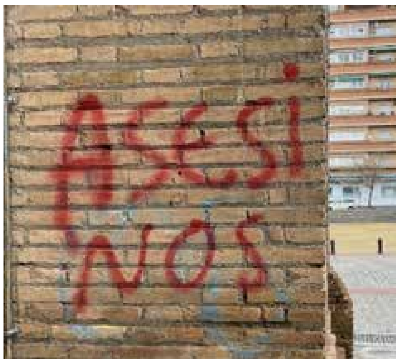
Figura 14. Fachada de la Plaza de Toros
