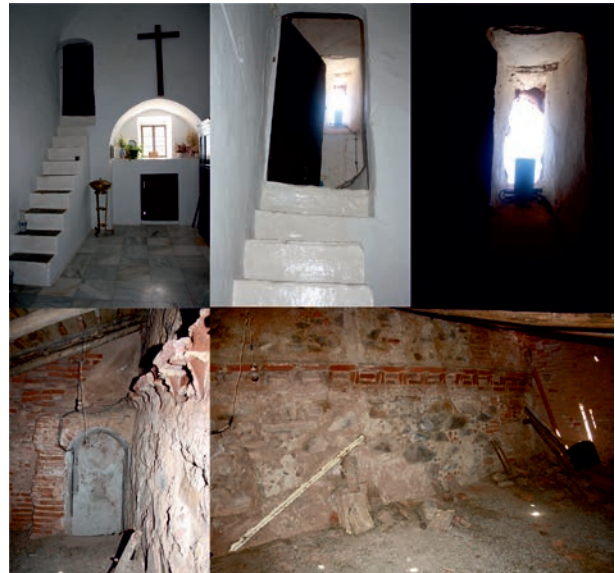
Figura 18. Imagen de la escalera de acceso a la cubierta de la sacristía, en origen de acceso a las terrazas de la torre atalaya, y de la merlatura preservada en la matriz de la Iglesia de Nuestra Señora de la Consolación erigida sobre las fábricas del castillo de Hinojales.
