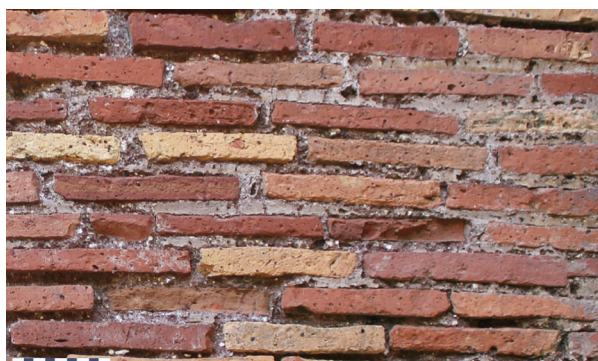
Figura 6. Dettaglio muratura con tracce di lisciatura. (Fase 1).
