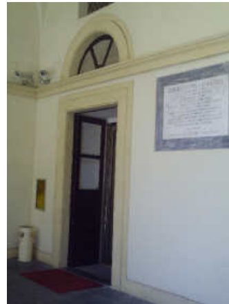
Entrada a los despachos del personal
